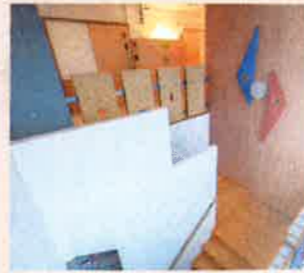
バリアフリーアパート。エレベーターが小さいこともあり、緊急時に担架で運ぶことも想定した階段がある
