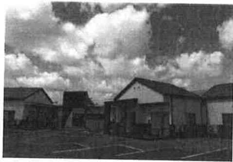
「サポートセンター摂田屋」の外観。グループホームなどの機能の他に、地域への配食サービスやカフェテラス、キッズルームも持つ
